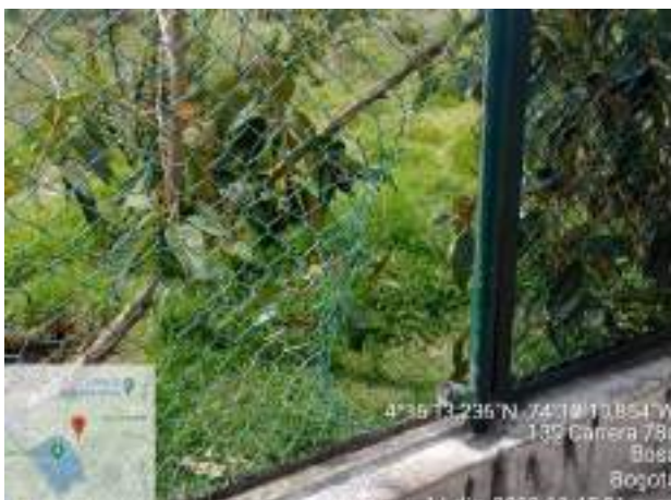
Figura 54. Ruptura de malla eslabonada del cerramiento perimetral del humedal de Tibanica, a la altura de la carrera 78 d en Bosa.
