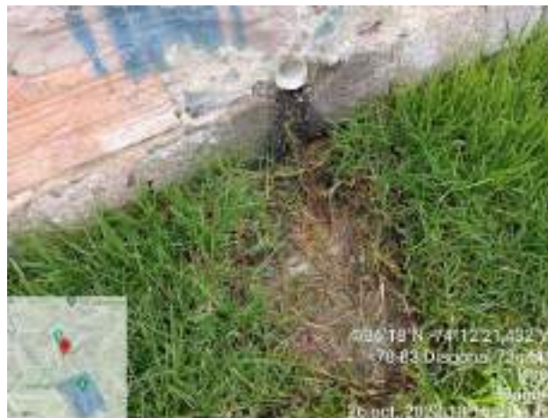
Figura 38.. Tubería de 3 pulgadas con zona húmeda proveniente de una vivienda al interior del humedal de Tibanica.
