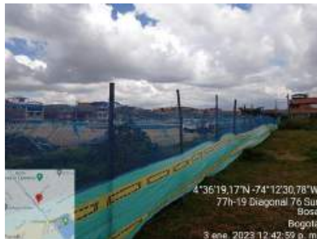
Figura 56. Instalación por parte del IDU de cerramiento provisional con alambre de púas y polisombra sobre el perímetro del humedal que colinda con las obras de construcción de la Avenida Ciudad de Cali
